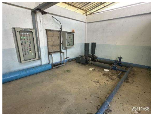
รูปที่ 3-1 ปั๊มเติมอากาศสำหรับระบบบำบัดน้ำเสีย
